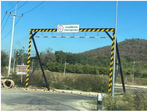
รูปที่ 2-9 การติดตั้งป้ายบอกระดับความสูงบริเวณทางลอดชุมชน
